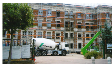
Travaux en cours
